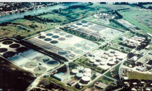
Station d'Épuration de Paris Achères, vue d'ensemble
