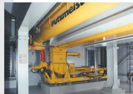
Dickstoffpumpe KOS 1460 und Notaustragsschnecke unter einem 500 m 3 Vorratssilo
