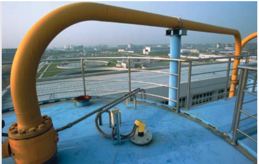
Silodach mit Befüllungsleitung, Entlüftungsstutzen und Ultraschallsonde zur Füllstandsmessung
