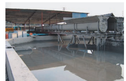
Der sedimentierte Schlamm wird von einem Bagger in die Speiseschnecken gefüllt
